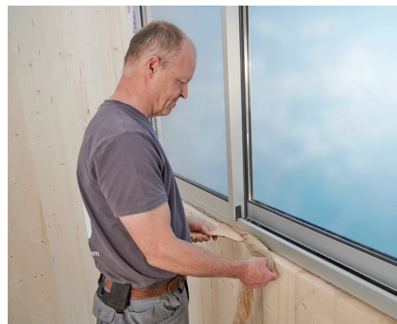
Einbau Fugenband
