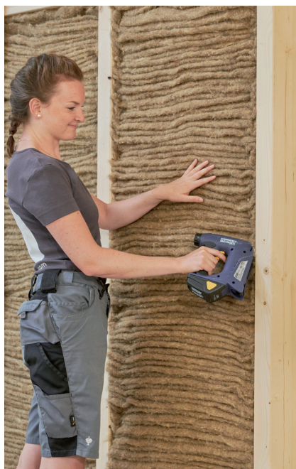
Die Dämmung wird „getackert“
